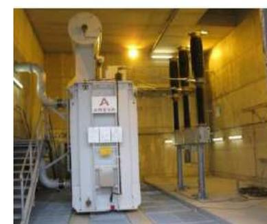
Survolteur-dévolteur ou booster bobine de compensation
